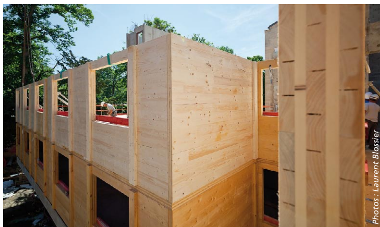
▲▲ Les panneaux Leno (Metsä Wood) mis en œuvre sur le chantier de la résidence universitaire La Fresque à Versailles (78).
